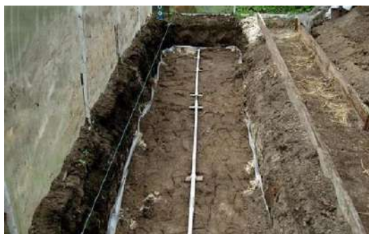
Рисунок 1.3 — Монтаж внутрішньогрунтової САП [4]
